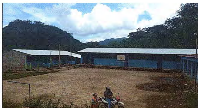
Foto 4: Finalización de mejoramiento cubierta de lámina, deteriorada por acumulación de partículas.
