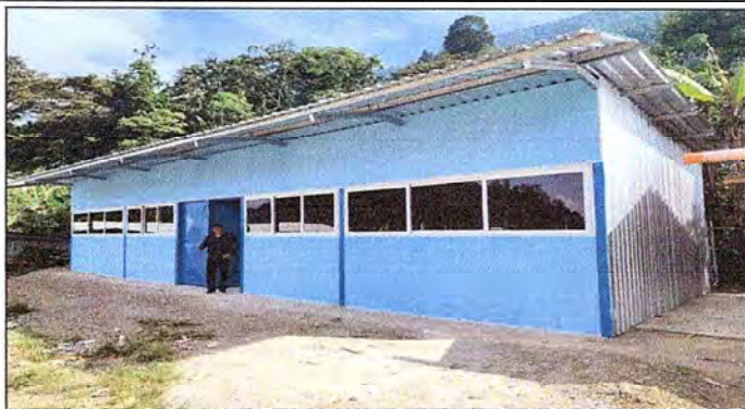
Foto 1: Modulo 1 finalizado compuesto de 2 aulas para mejorar las condiciones de los estudiantes (vista frontal).
