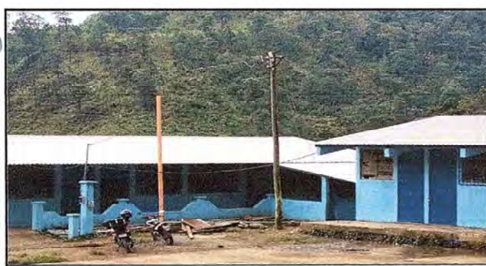
Foto 5: Finalización de mejoramiento cubierta de lámina, deteriorada por acumulación de partículas.
