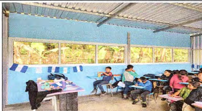
Foto 2: Modulo 1 finalizado compuesto de 2 aulas para mejorar las condiciones de los estudiantes (vista interior).
