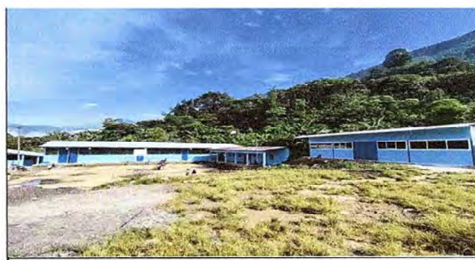
Foto 6: Finalización de pintura exterior en todos los modulos del establecimiento educativo.
