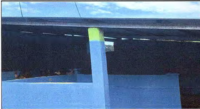
Foto 7: Finalización instalación de estructura de metal y lámina para mejorar las condiciones del ambiente.
